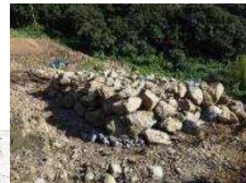
【写真】転石発生状況
