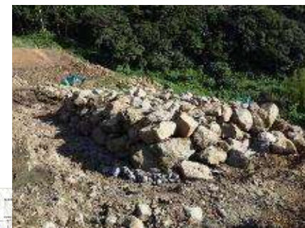
【写真】転石発生状況
