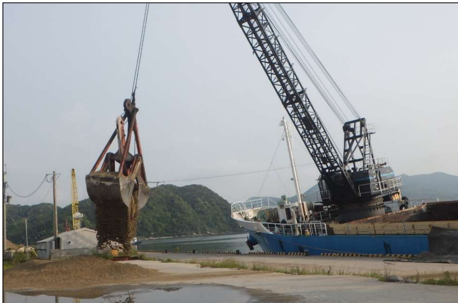
▲岸壁（-5.5m）における砂揚状況
