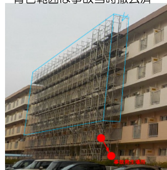
現地の足場状況 青色範囲は事故当時撤去済
