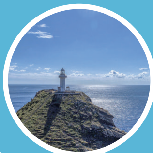
五島市 『大瀬崎灯台』
