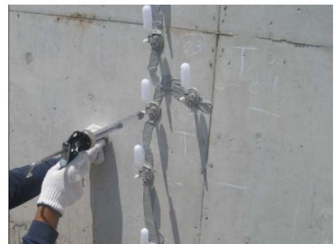
写真-3.2.2 自動式低圧樹脂注入工例
