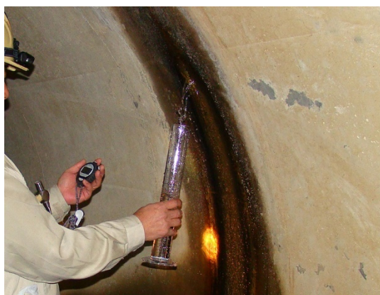
図-2.5.4 漏水量調査
