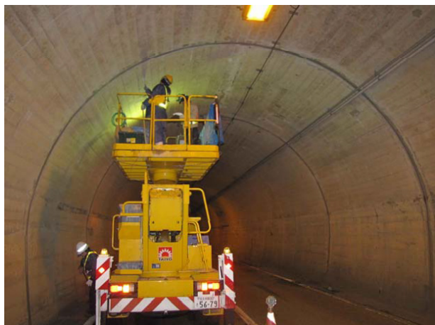
図-2.5.2 近接目視点検
