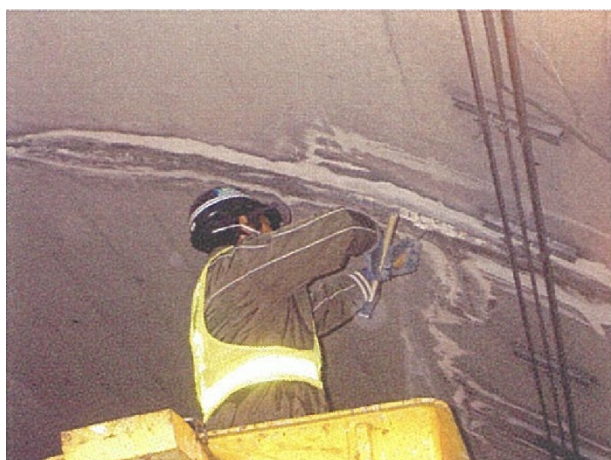
図-2.5.5 応急措置（うき・はく離除去）
