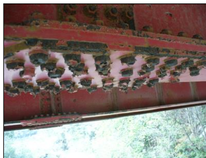
主桁-腐食
