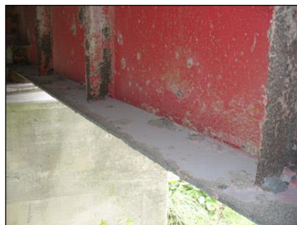
主桁-腐食
