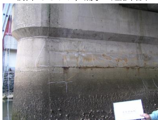
橋脚-ひびわれ，漏水・遊離石灰
