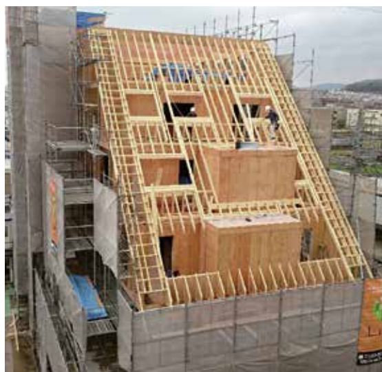
■ 2×4 工法による 5 階建て商業ビルの例
