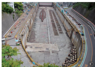
三菱長崎造船所 第三船渠(長崎市飽の浦町) © 1905年に建設された大型船の修理施設(ドック)。船の大型化にともなって3度拡張された。
