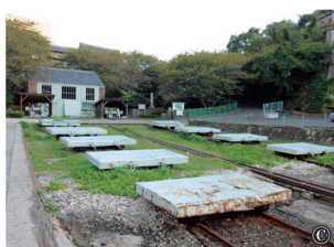
小菅修船場跡(長崎県小菅町) © 1869年、薩摩藩とグラバーによって建設された日本最初の蒸気機関による曳揚げ装置を備えた船の修理施設(スリップドック)。
