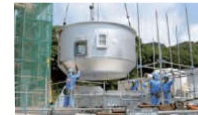
クリーンセンターの機械設置
