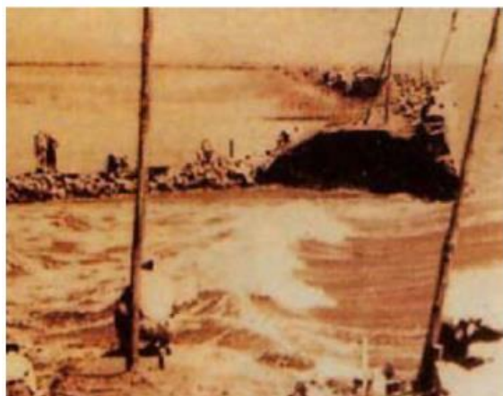
写真1 写真 破堤状況（佐賀県芦刈海岸） 昭和31年8月台風9号
