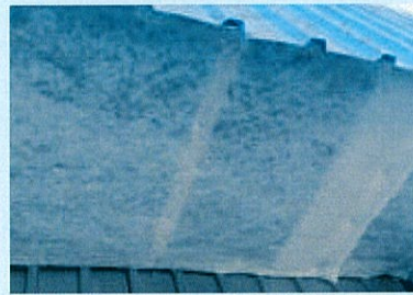
▲入気口フィルターの設置
