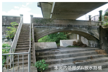
本河内低部ダム放水路橋
