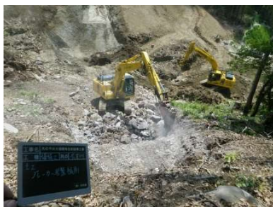
粉塵を巻き上げながらのブレーカー 破碎状況
