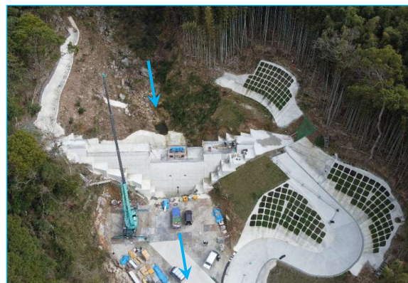
施工状況(令和6年3月)
