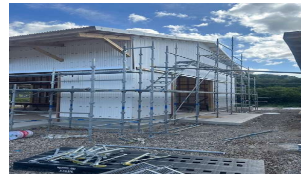
【大工作業用足場の組立】
