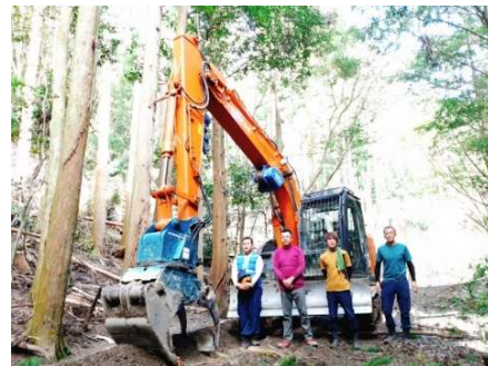
現場技能者と林業機械
