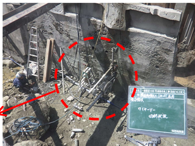
ワイヤーソー施工状況
