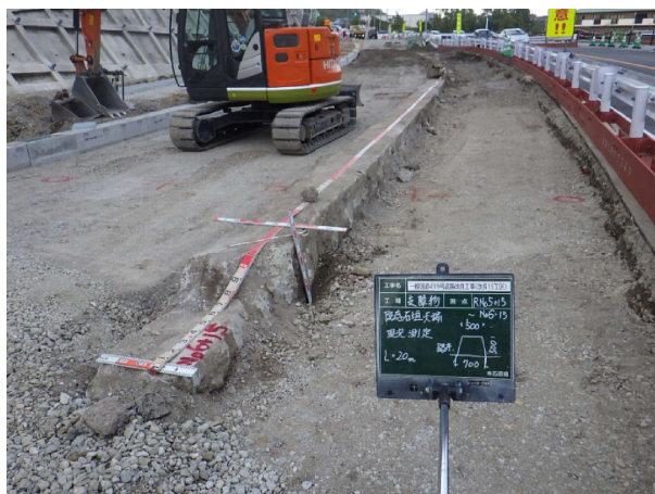
埋設物の状況①
