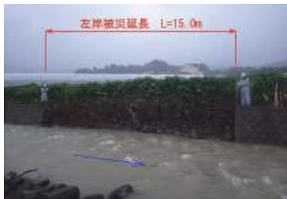
被災箇所の測量
