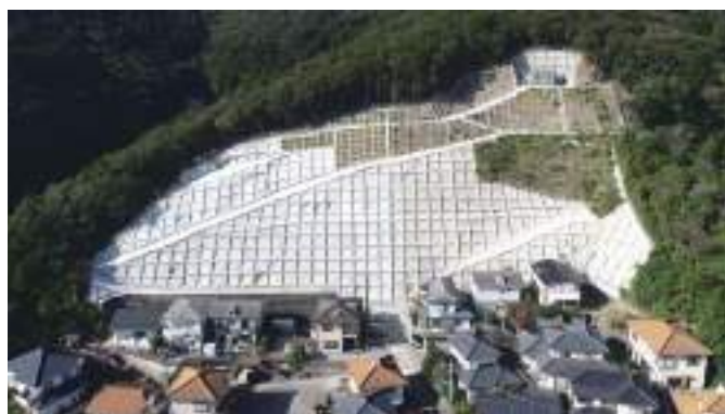
令和5年度概成 白川地区急傾斜地崩壊対策事業（対馬市）
