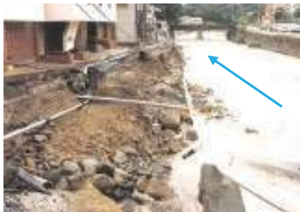
長崎大水害（S57.7.23）の被災状況
