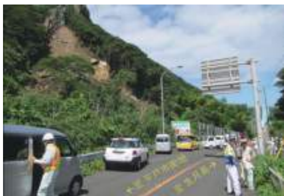
落石等による被害の復旧作業
