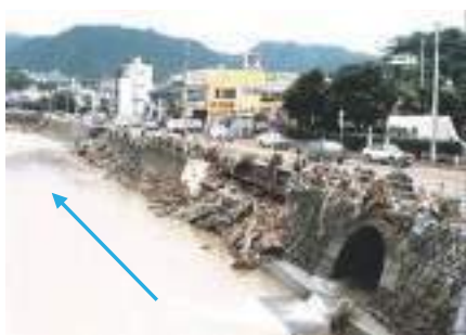
長崎大水害（S57.7.23）の被災状況
