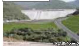
石木ダム(川棚町)
