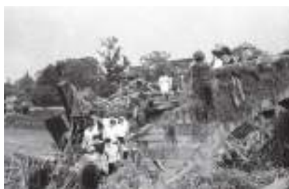
諫早大水害（S32.7.25）の被災状況
