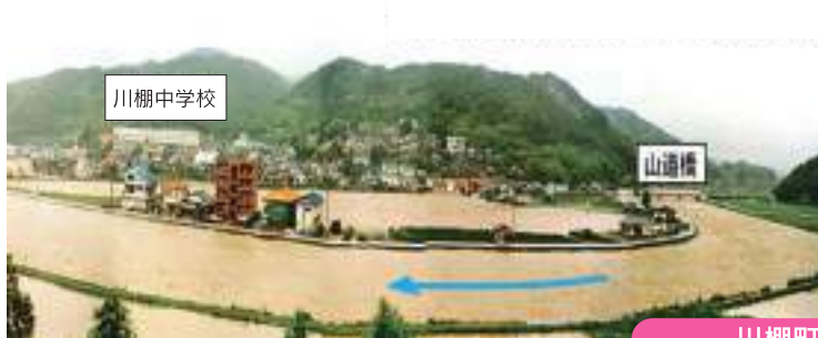
平成2年水害（H2.7.2）の被災状況
