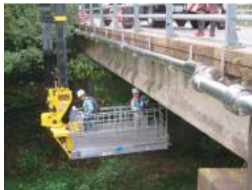
橋梁の定期点検状況
