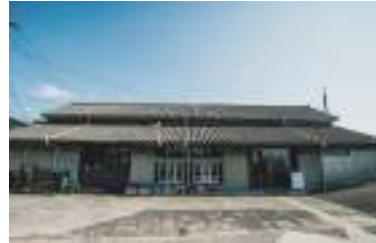
旧千綿村農協米倉庫
