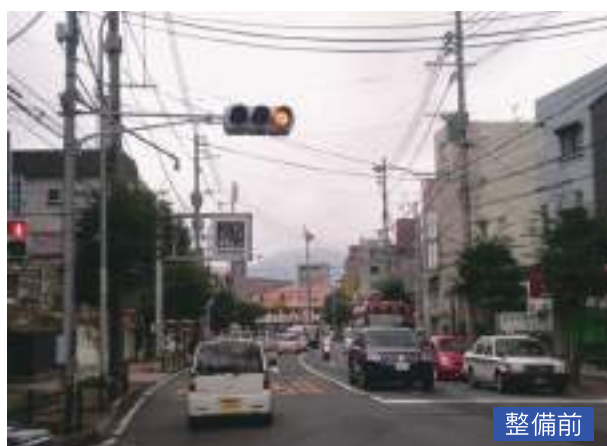
〈一般県道長与大橋町線（長崎市昭和町地区）〉
