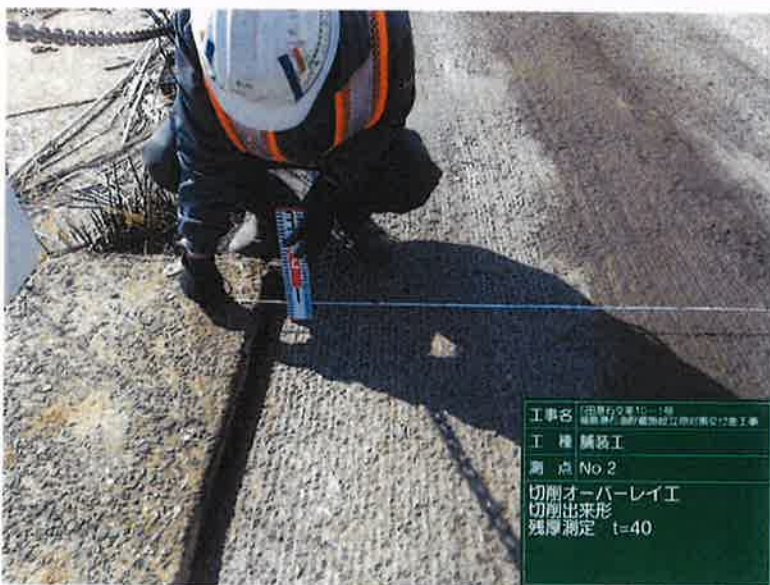
工種：舗装工 測点：No.2
