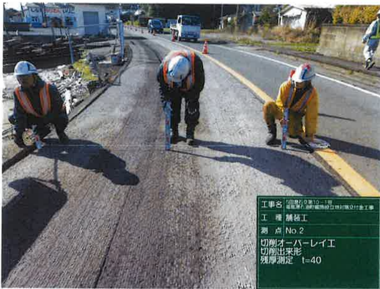
工種：舗装工 測点：No.2
