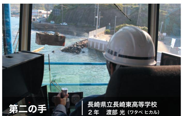
撤去するブロックをクレーンで浚渫船へ移しているときの一枚。何十トンもあるブロックを手元のレバーを駆使して運んでいる。少しでも操作を誤ってしまうと惨事になりかねない。操縦士は大きいクレーンを自分の手であるかのように、慣れた手つきで慎重に動かしていた。淡々と仕事を終えた操縦士の姿はとてもかっこよかった。
