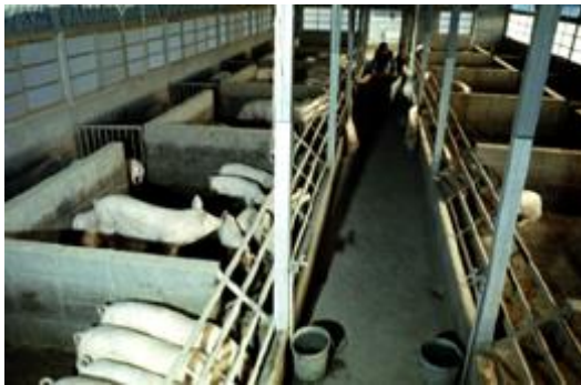
【コンクリート床豚舎】（デンマーク式）
