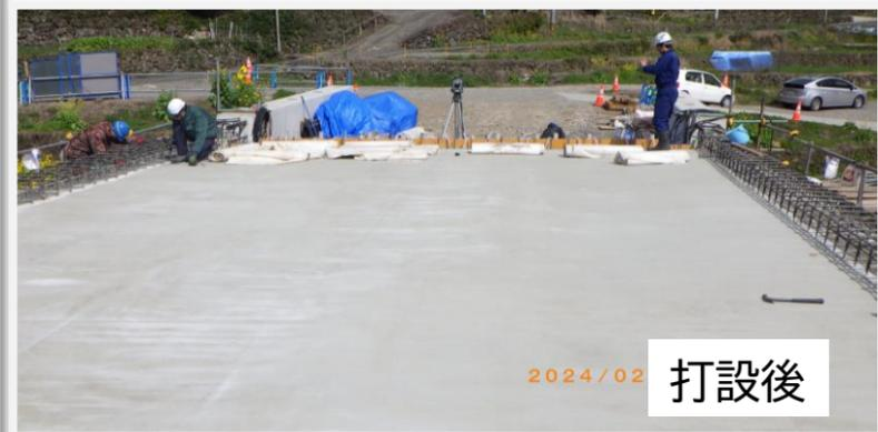
付替県道6号橋上部工事（木場郷下木場）において、主桁部分のコンクリート打設が完了しました。引き続き完成に向けて進捗を図っていきます。
