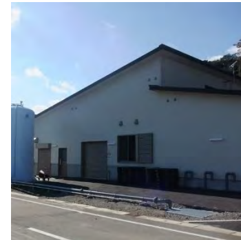
整備した委託加工施設
