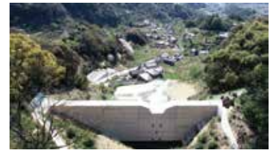
長崎県上戸石町大坂川の砂防堰堤
