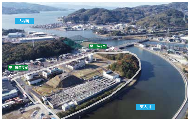
大村湾南部浄化センター
