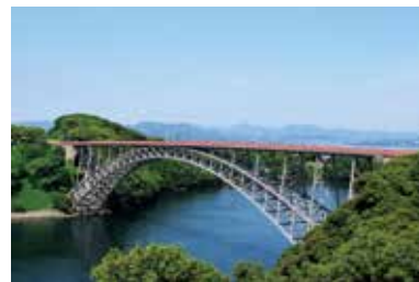
西海橋(国指定重要文化財(建造物))
