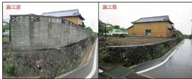
危険ブロック塀除去事例
