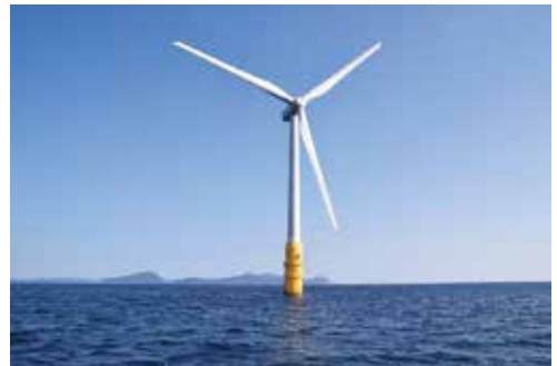
五島市沖浮体式洋上風力発電「はえんかぜ」
