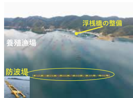
整備が進む養殖漁場を守る防波堤と浮棧橋
