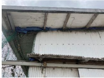
屋根と壁の間に詰物をした野鳥侵入対策例 (採卵鶏舎)
