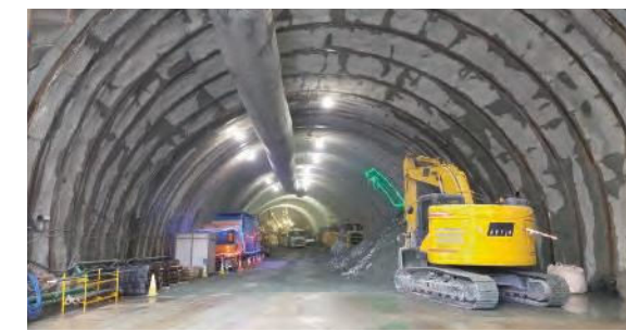
江川トンネル(仮称)施工状況
