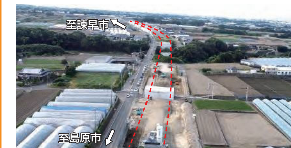
出平有明バイパス施工状況(島原市原口町付近)
