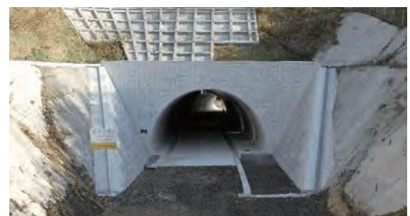
令和5年3月に貫通した坪トンネル
