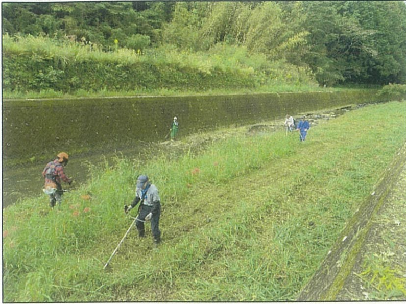
伐採作業中のようす
