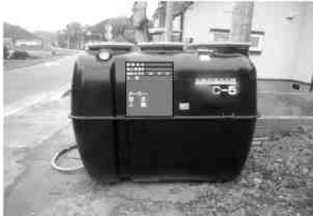
写真(浄化槽本体搬入の写真)
