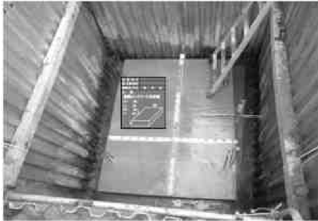
写真(基礎コンクリート仕上り状況)
