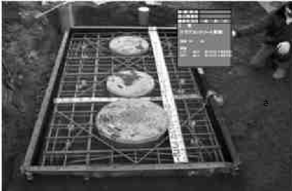
写真(上部スラブコンクリート配筋状況)
