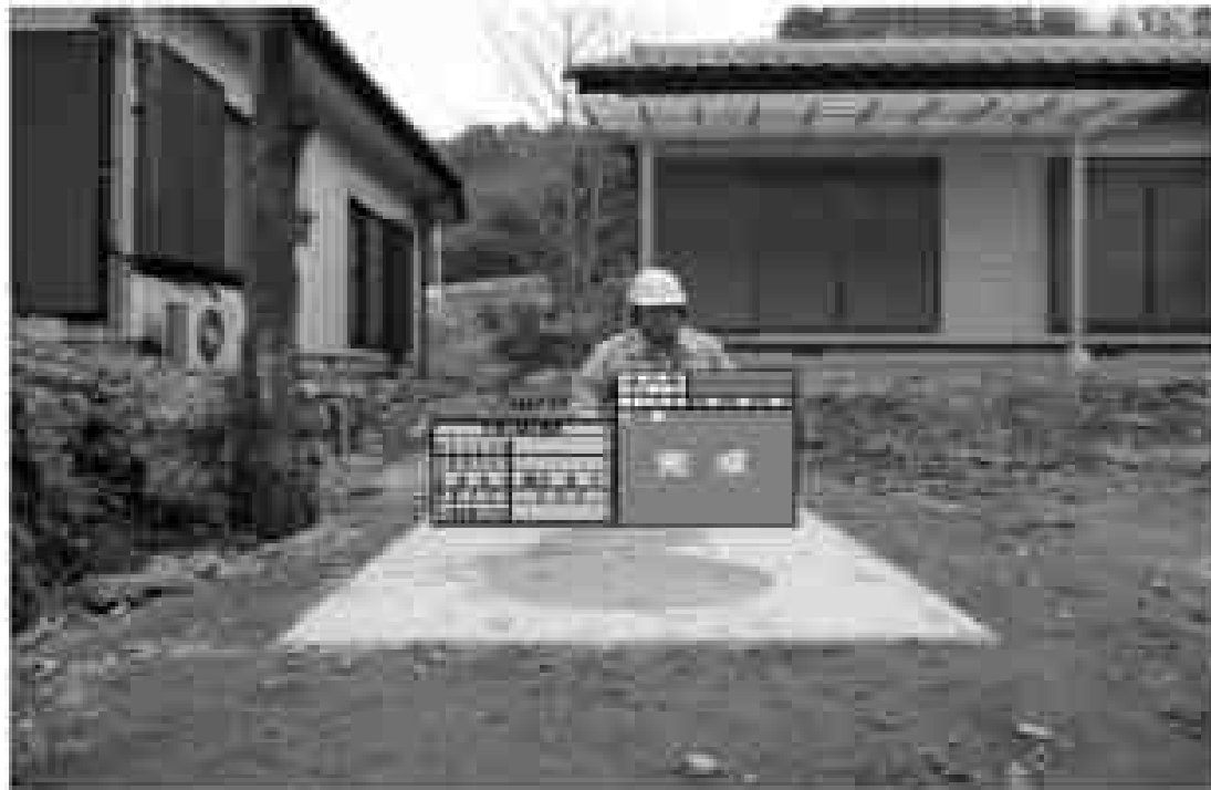
写真(完成状況)
