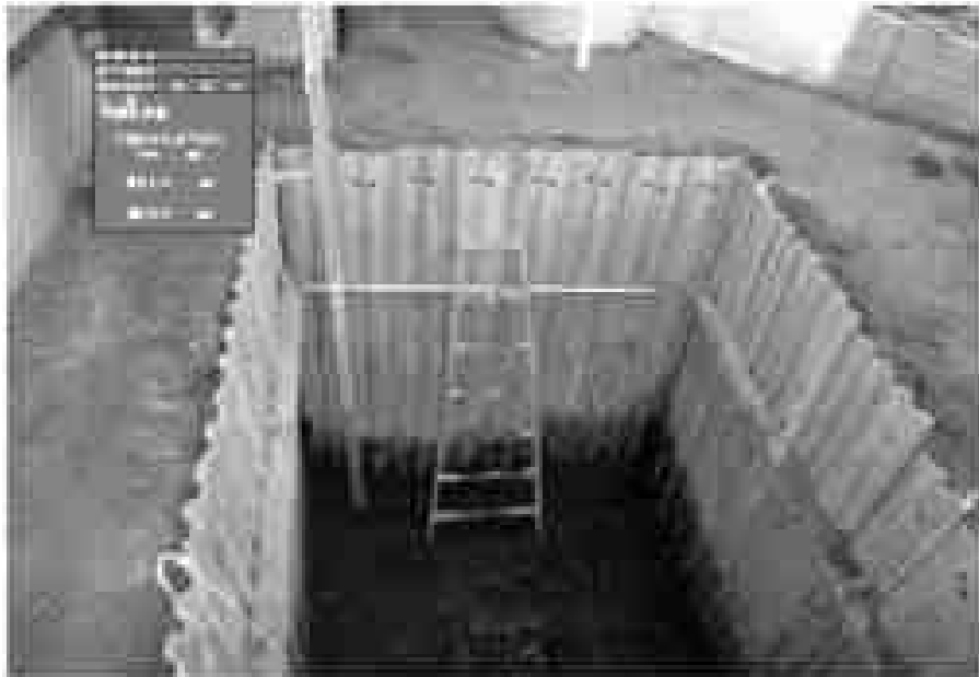
写真(床付け完了状況)
