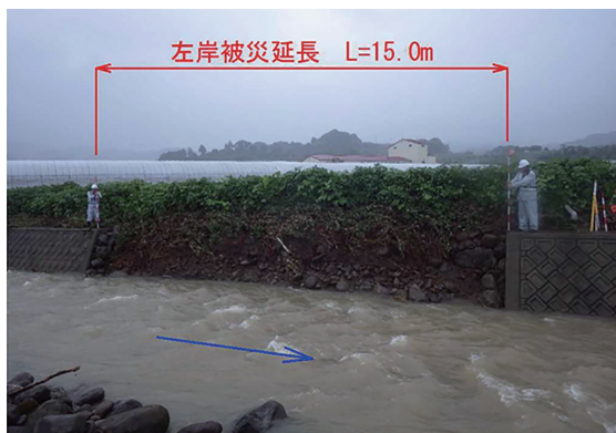
被災箇所の測量
