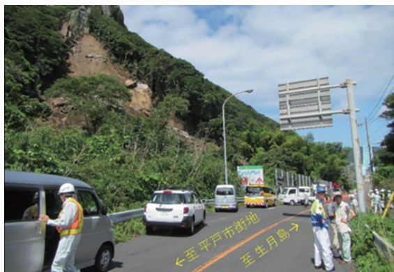
落石等による被害の復旧作業
