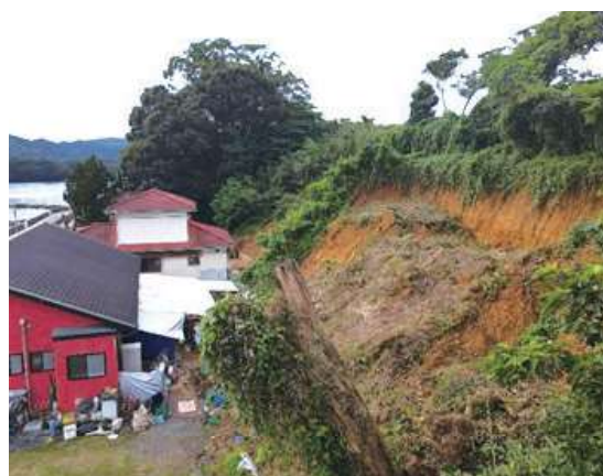
人家隣接の斜面が崩落（令和3年 西海市）
