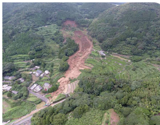
地すべりによる被災状況（令和2年 佐世保市牧の地地区）
