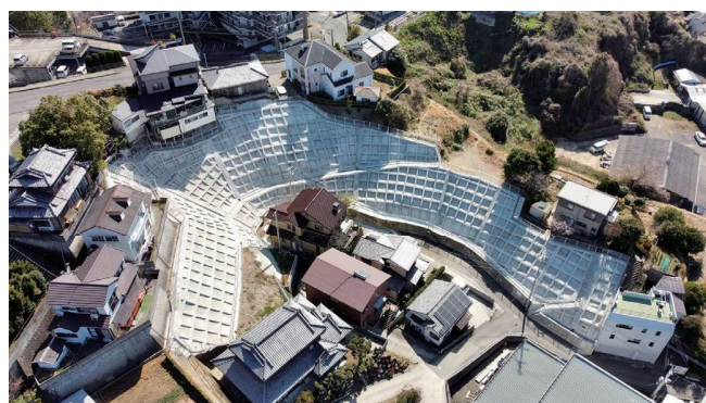
斜面下部の多くの人家を保全している法面工（長崎市 田中(61)地区）
