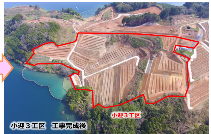
○工事完成後の状況【令和4年3月撮影】
