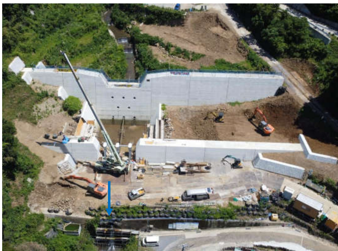
山口谷川砂防施工状況
