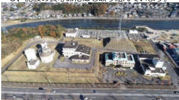
大村湾南部浄化センター
