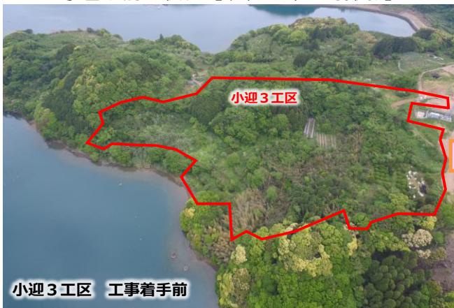
○工事着手前の状況【令和3年4月撮影】
