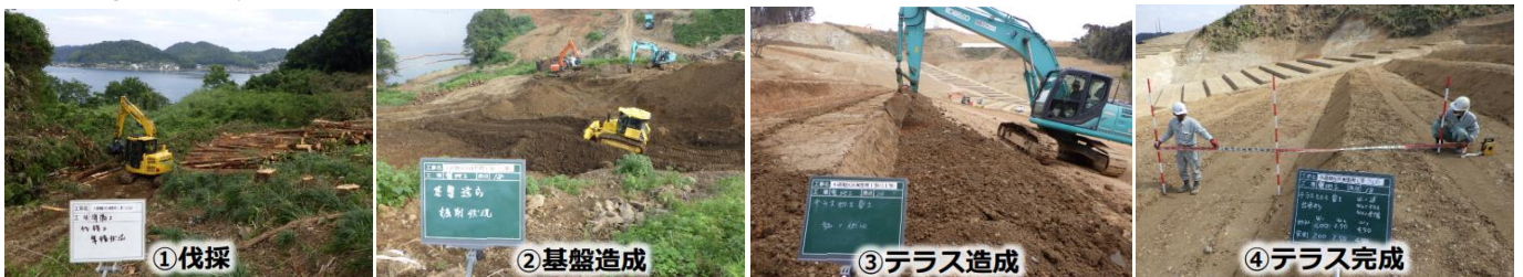
○工事の施工状況
