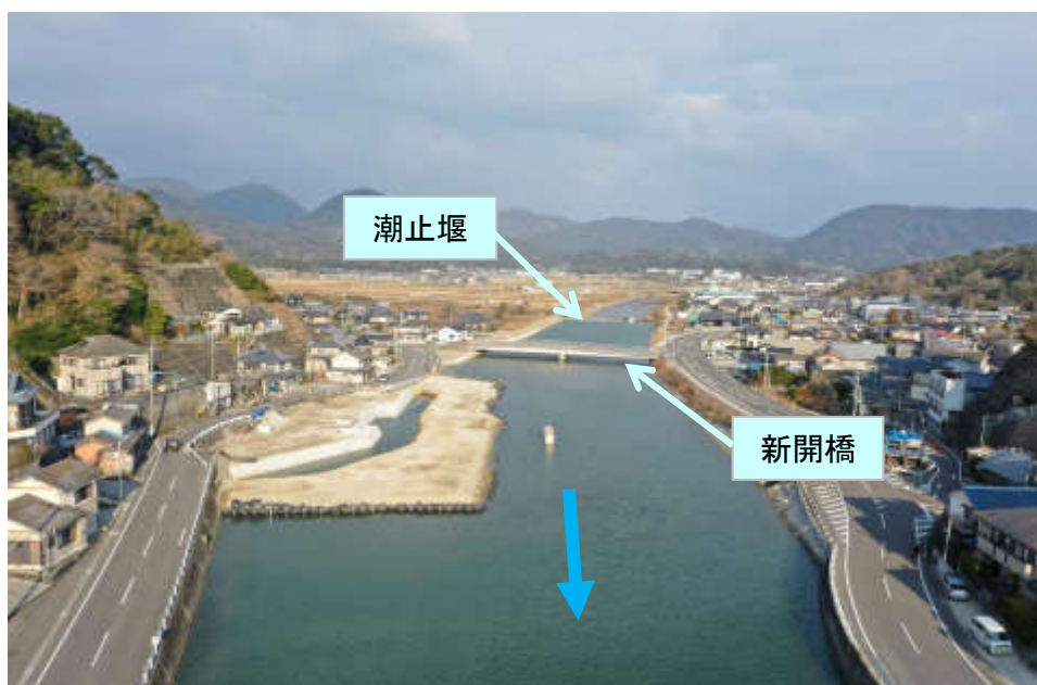
江ノ浦川河川改修工事（施工状況）
