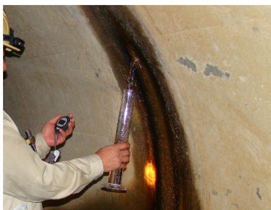
図-2.5.4 漏水量調査
