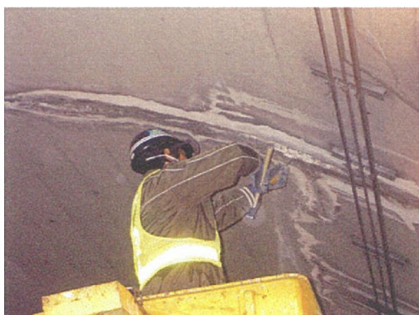
図-2.5.5 応急措置（うき・はく離除去）
