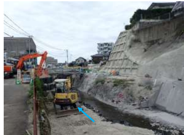
令和4年度施工（護岸工・法面工）
