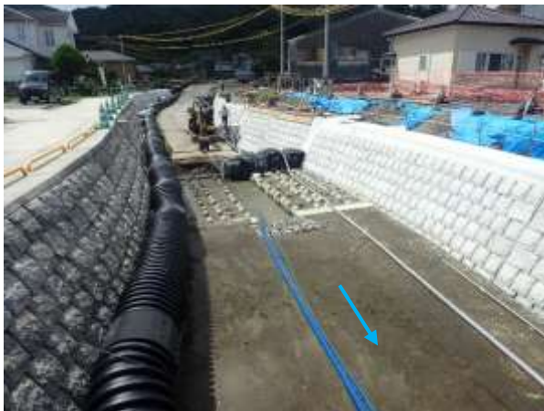
令和4年度施工（護岸工）
