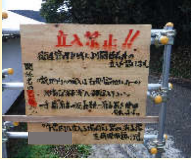
関係者以外の立入を禁止する 看板設置
