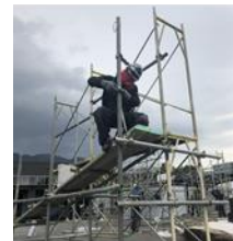
足場仮設工事
