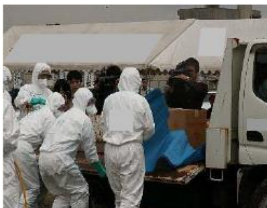
フレコンバッグをトラックへ積載する際の補助（ブルーシートかけ等）
