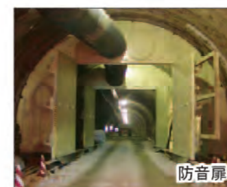
①防音扉 ②土砂仮置き場(防音ハウス内) ③バッチャープラント ④濁水処理プラント
