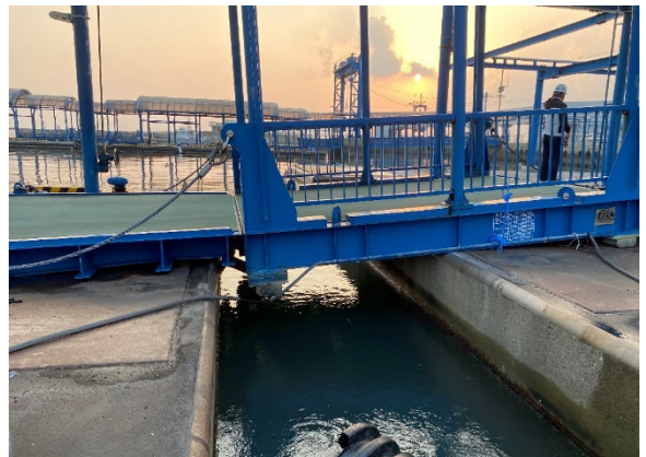
福江港 (浮棧橋渡橋)
