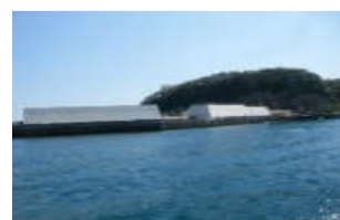
高浜漁港水産生産基盤整備工事
