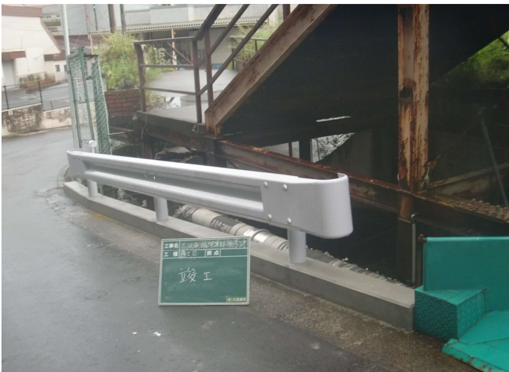
地点①着工後
