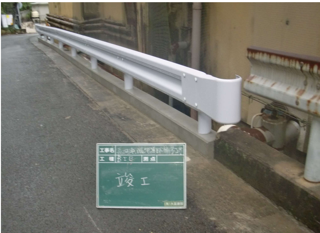
地点②着工後
