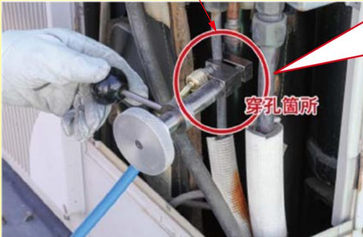
室外機の配管に穿孔している様子
