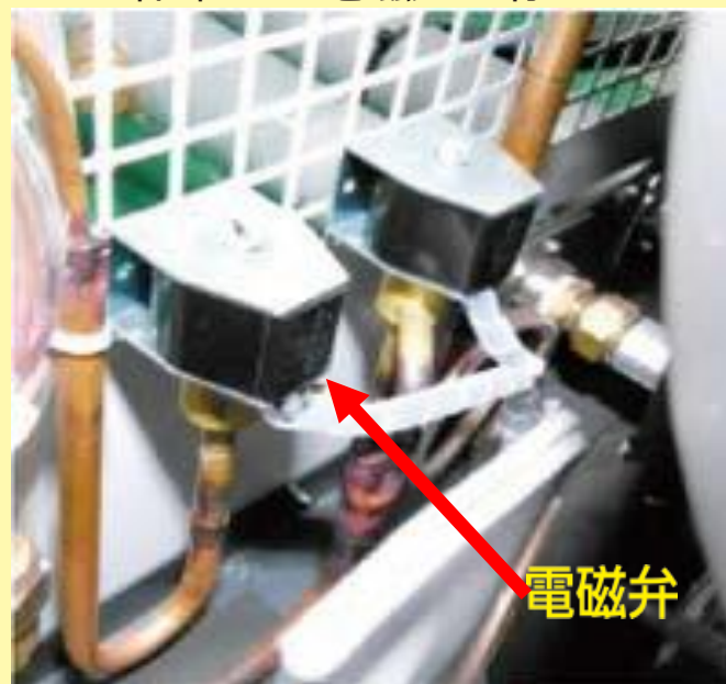
作業前の電磁弁の様子
