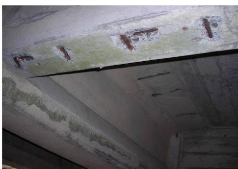
コンクリート桁の剥離・鉄筋露出
