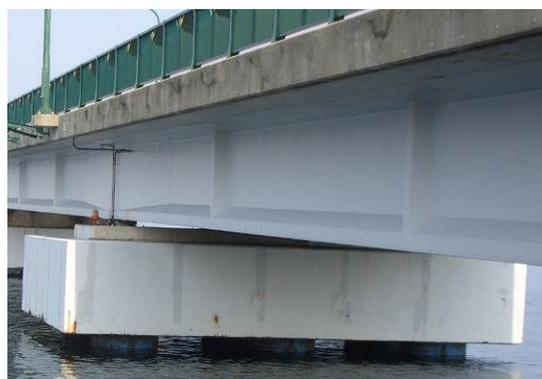
塩害、アルカリ骨材反応の対策後 (主桁、下部工のコンクリート表面被覆工)
