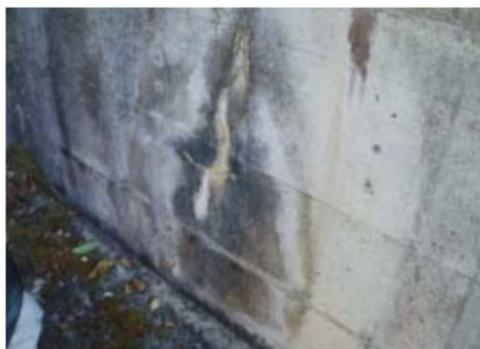
橋台躯体のひびわれ、漏水、遊離石灰
