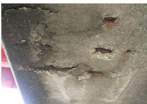
橋脚梁下の剥離・鉄筋露出
