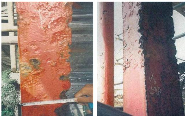
旧橋：鉛直鋼材の腐食
