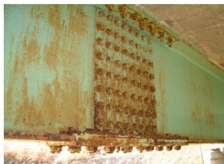
鋼桁の防蝕機能の劣化
