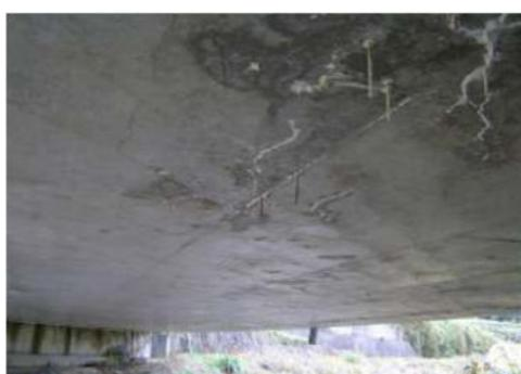
コンクリート桁のひびわれ、遊離石灰
