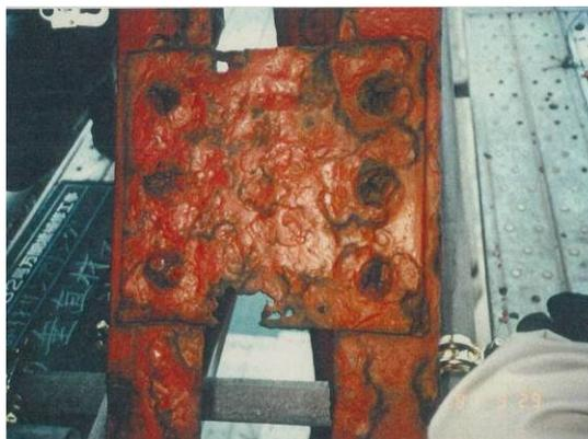
旧橋：対傾構鋼板の腐食
