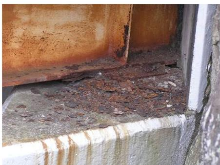
鋼桁、支承の腐食
