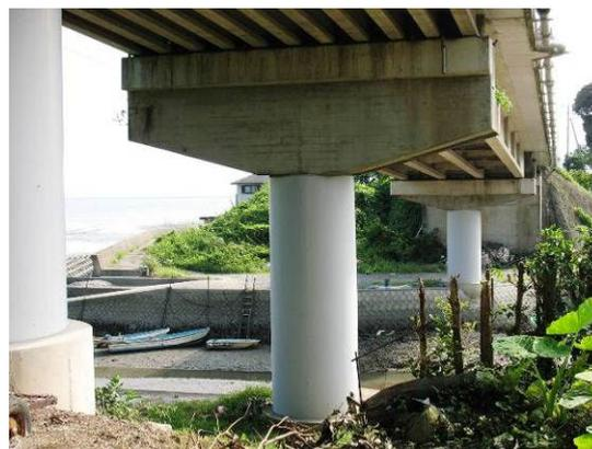
橋脚柱の補強、沓座拡幅
