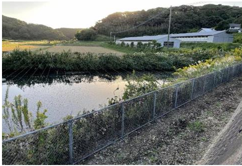
図-9 対策実施後（ため池1）
