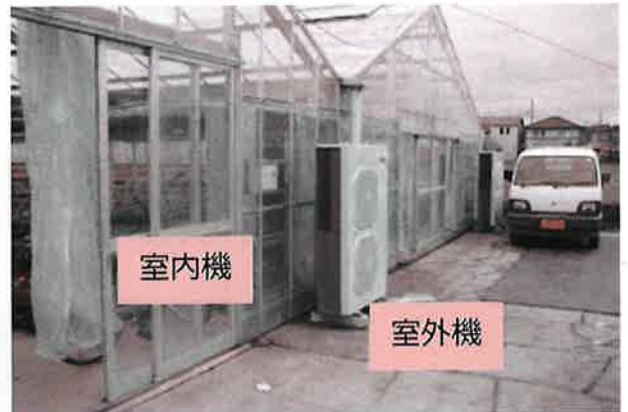
室内機と室外機の適切な設置例
