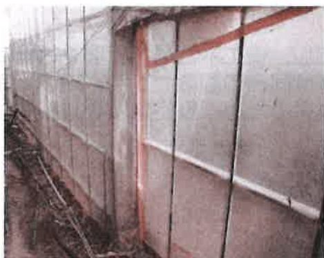
外張被覆の隙間を目張り
