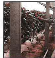
ブレースの増設
