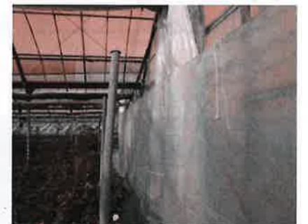
妻面のカーテンの隙間対策②
