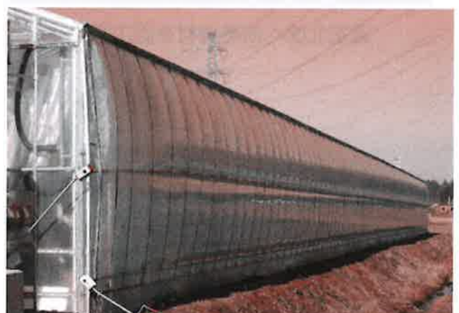
空気膜2重被覆(側面部)
