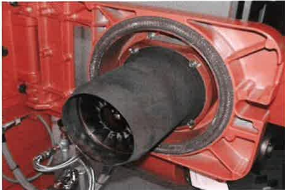
清掃前、ススで真っ黒のエアコーン、 ディフューザーの状態
