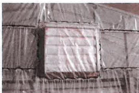
換気扇のシャッターを目張り
