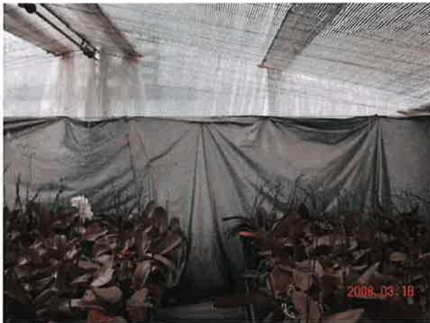
温室北面へ断熱資材を固定張り
