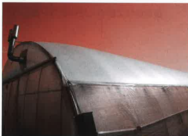
空気膜2重被覆(屋根部)
