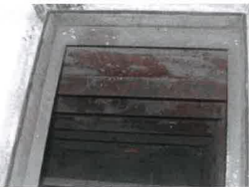
腐食抑制剤を使用している缶体
