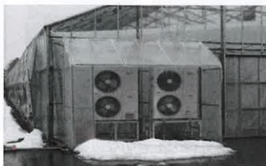
デフロスト水や積雪の影響に対応した適切な設置(例)
