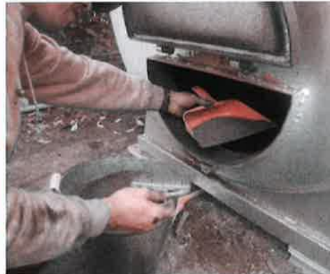
木質バイオマス暖房機の燃焼灰の清掃
