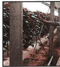
ブレースの増設
