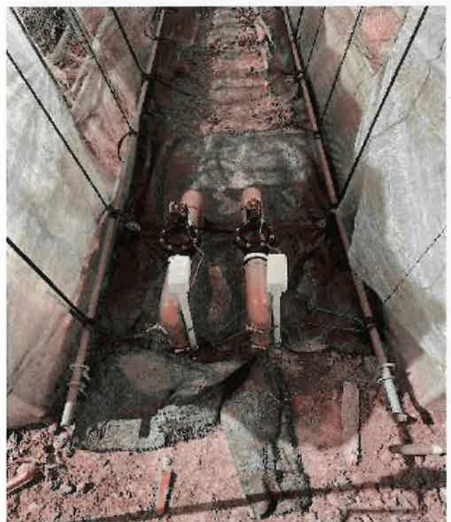
タイマーにより開閉する電磁弁
