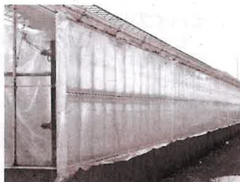
外張被覆をスプリング留め具で固定
