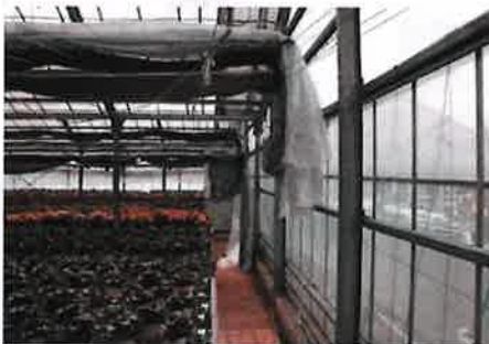
妻面のカーテンの隙間
