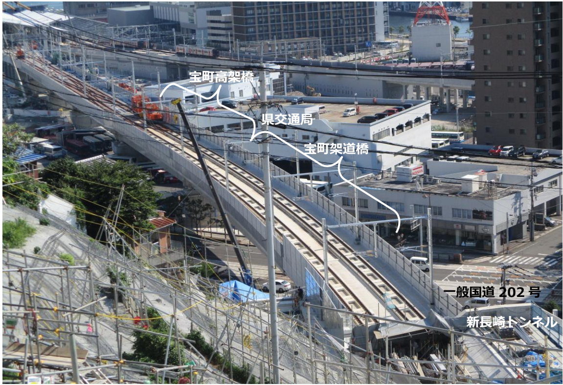
完成した宝町橋りょう
