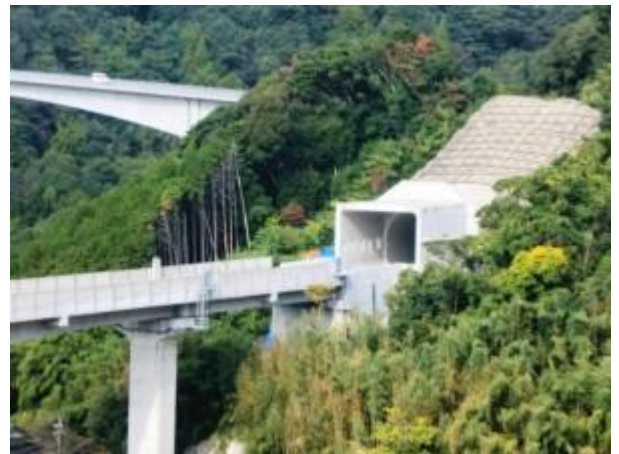
【塩鶴トンネル終点側】
