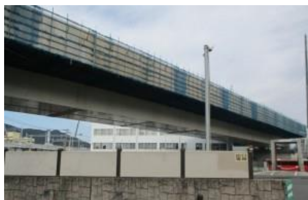
【橋桁降下後(R1.10.21 撮影)】
