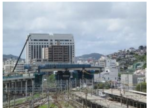
【送り出し架設後、橋桁降下前(R1.7.11 撮影)】
